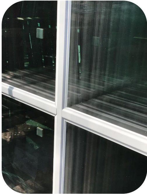
Sprossen ohne Klapperschutz
