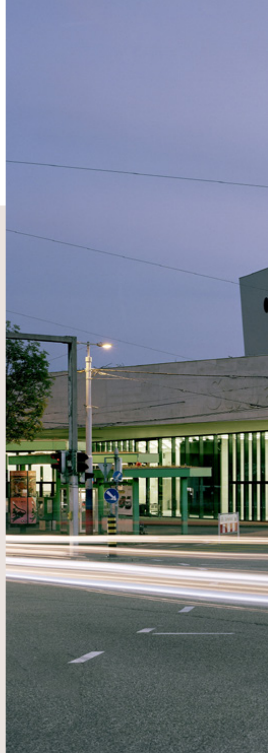
1. Fassadengläser: TG-ESG®-H 10 mm 50/22 II, 16 mm CU SZR, TG-ESG®-H 8 mm ONE II, 16 mm CU SZR, TG-ESG®-H 10 mm von SAINT-GOBAIN.
